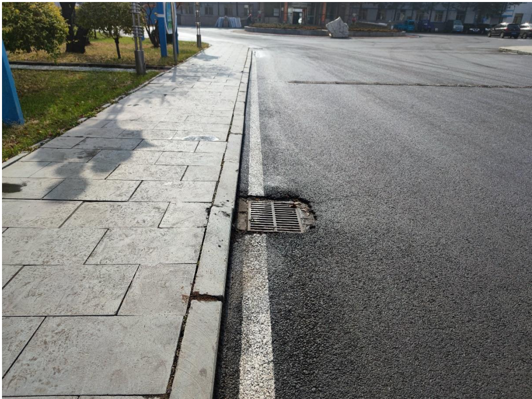
工业厂区排水沟
